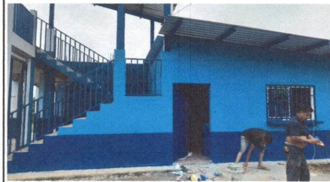
Foto 3: Sustitución de Puerta
